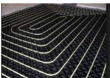
Polaganje cijevi vidljivo je u grafičkom dijelu projekta. Krugovi PE-Xc/ cijevi dovode se i spajaju na razdjelnik podnog grijanja/hlađenja koji je standardne tvorničke izvedbe. Razdjelnik (RPG) se sastoji od slijedećih elemenata:
